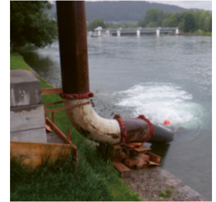
Grundwasser von der Baustelle beim Bahnhof Dietikon wird in die Limmat zurückgegeben
