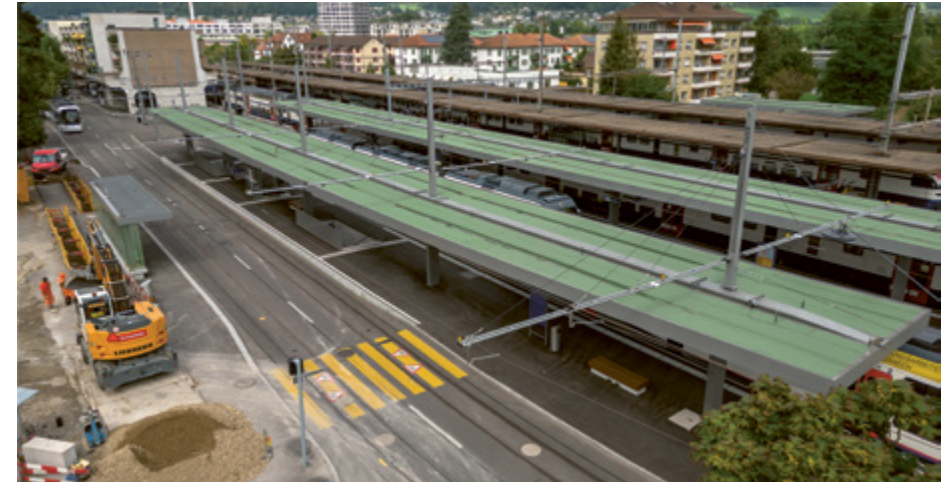
Neu gestalteter Umsteigebereich am Bahnhof Dietikon mit neuen Perrondächern
